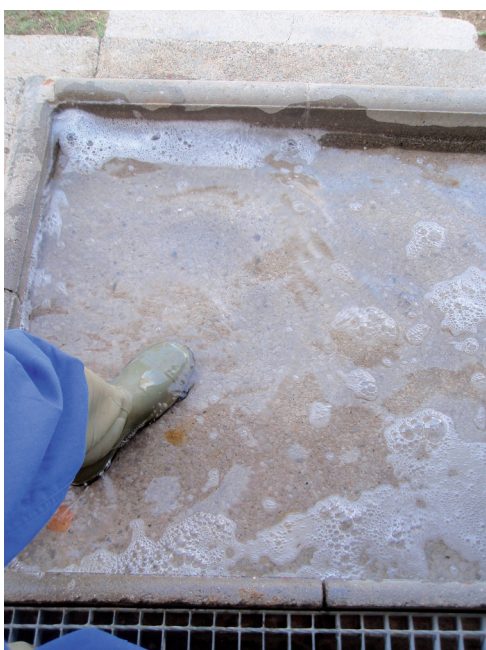
Pediluvio para la desinfección del calzado
